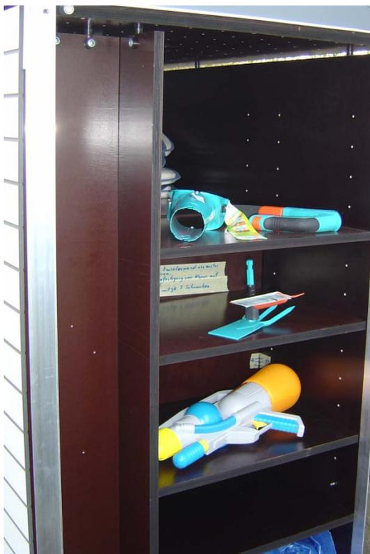
**Im Inneren** besteht der Garten[Q]Teras aus **beschichteten Siebdruck-Platten**. Sie kennen dieses Material von Bodenplatten in Autoanhängern. Es ist extrem widerstandsfähig, stabil und feuchtigkeitsgeschützt. Da macht es auch nichts aus, wenn etwas feucht oder verschmutzt hinein gelegt wird.
